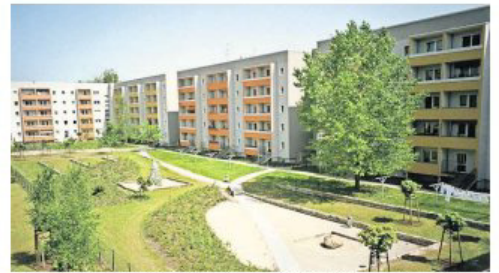
Die in der Wendezeit in Plattenbauweise errichteten Gebäude an der Adler- und Falkenstraße wurden vollständig saniert.
